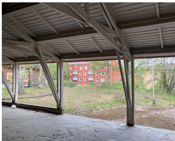
Näkymä rakennukset yhdistävän käytävän katoksen sisältä. Liuskekivilaatoitus on hyväkuntoinen.
