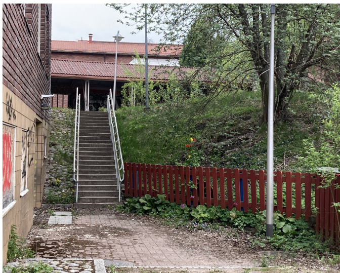
Kulkuväylä rakennuksen koilliskulmalta yläsisäpihalle.
