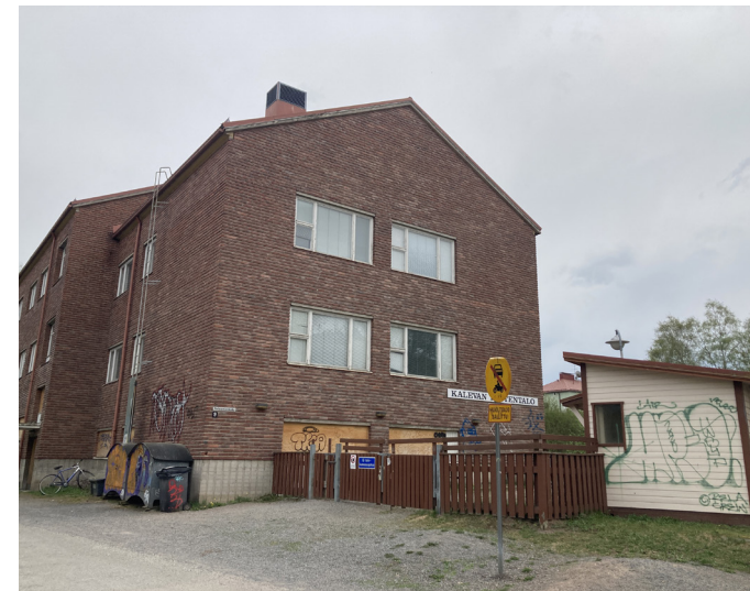
Pohjoisen rakennuksen itäpääty, jossa kyltti "Kalevan lastentalo". Oikealla leikkivälinevarasto.
